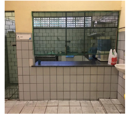
Figura 16 – Balcão do refeitório.
