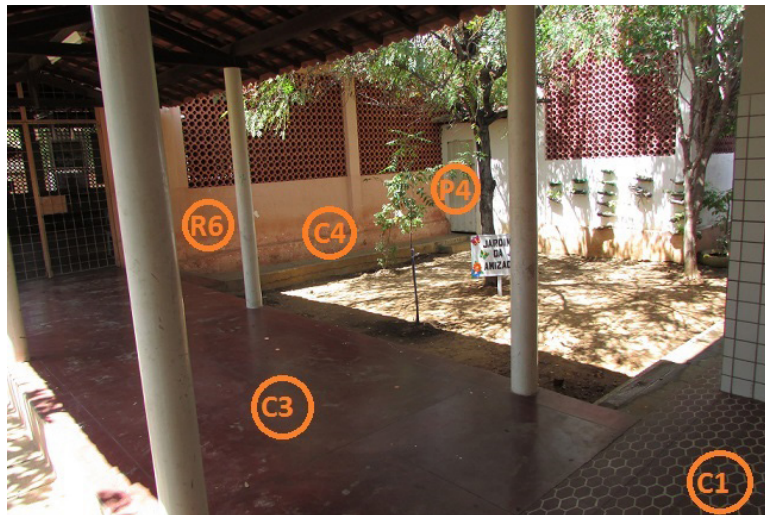
Figura 6 – Áreas de circulação e rampa R6 de acesso à biblioteca P4.
