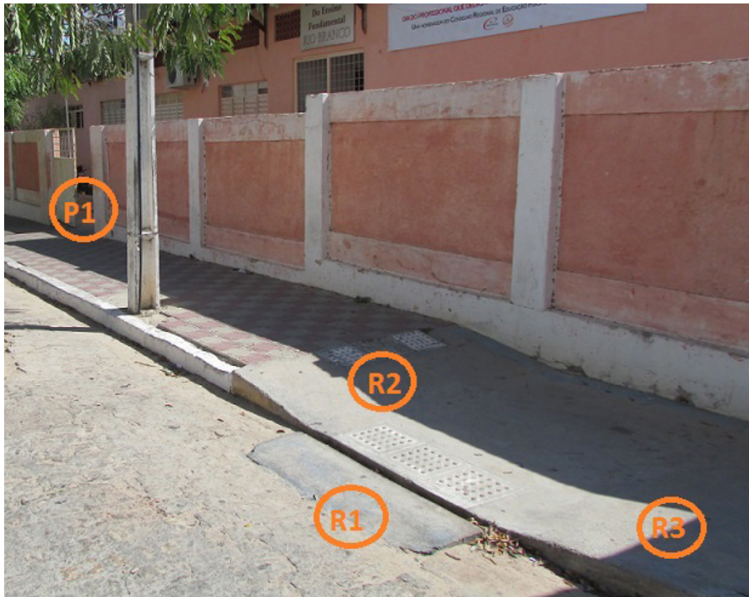
Figura 2 – Rampa de acesso à calçada da escola – Acervo pessoal.
