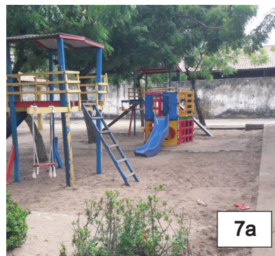
Figura 7 – Playground sem pavimentação.
