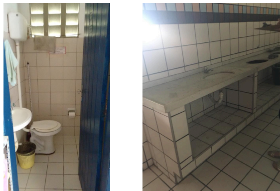
Figura 25 – Banheiro de funcionários.
