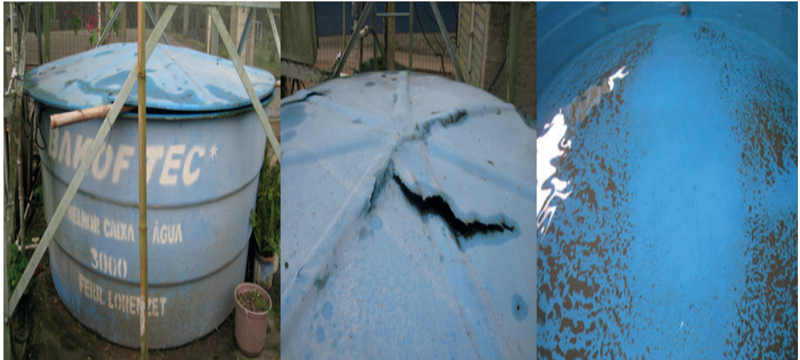
Figura 3: Condições externas e internas do reservatório da água consumida na Escola 1.
