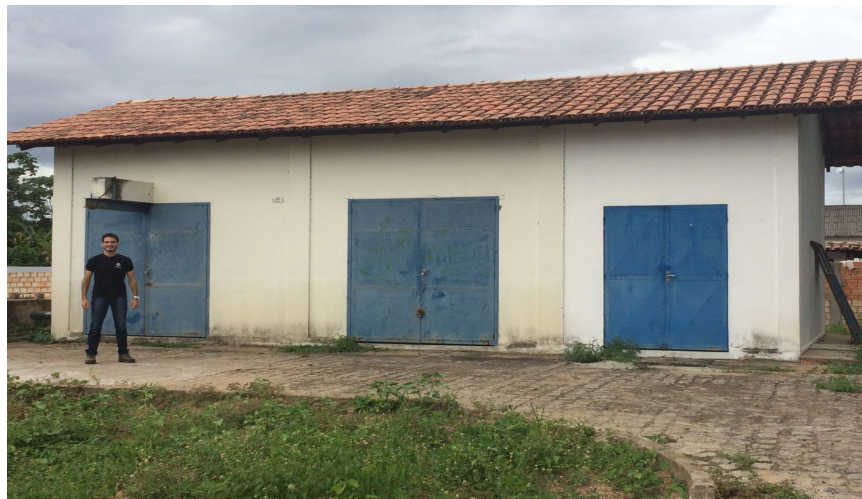
Figura 4 – Estação elevatória de esgoto Paraviana.
