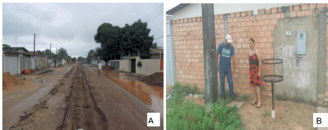
Figura 06: A - 4º Etapa lote B área 18. B - Ramal de esgoto Sanitário.
