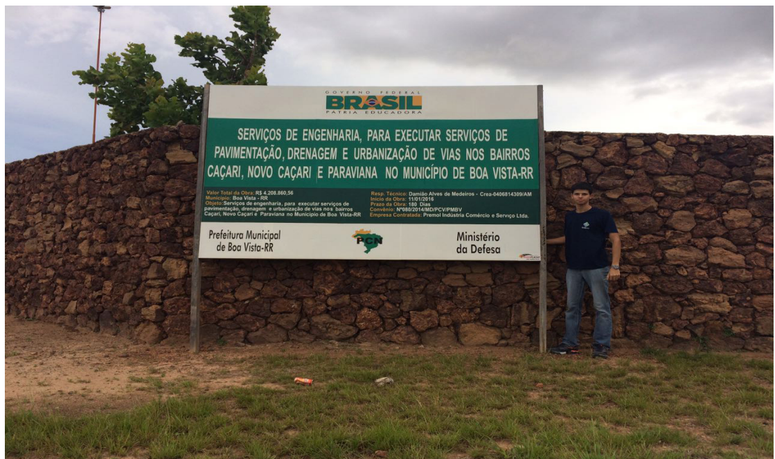
Figura 7 – Placa da Obra de extensão da rede de drenagem pluvial.
