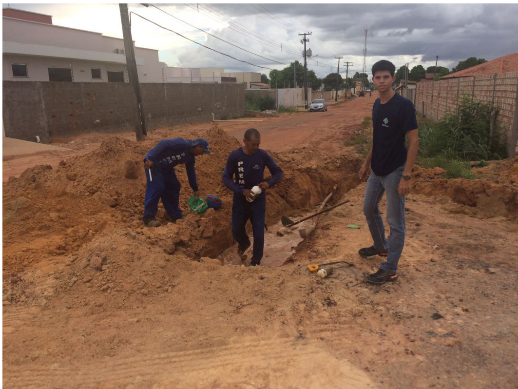
Figura 9 – Obra de extensão da rede de drenagem pluvial em andamento. Autor: Maikon Barros, 2017..
