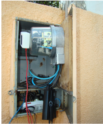
Figura 23. Detalhe do acoplamento da câmera ao medidor de energia.
