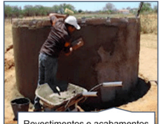
Revestimentos e acabamentos com argamassa de cimento em cisterna de placas
