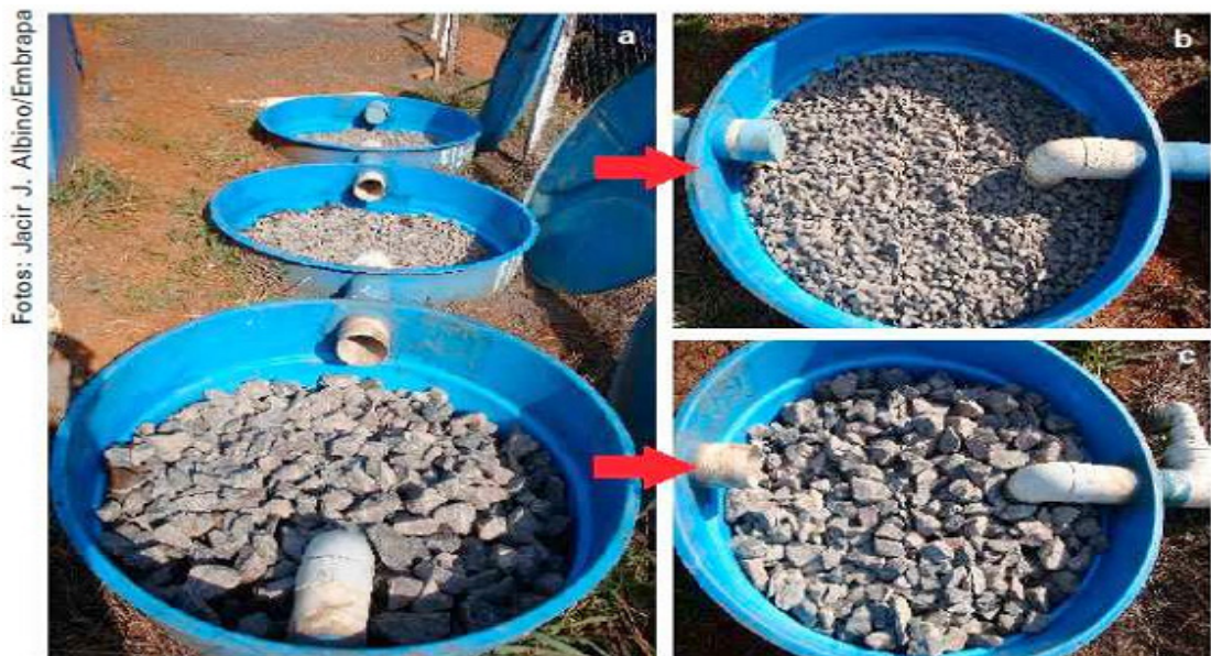
Figura 6 – Sistema de Filtração para grande vazão utilizando caixas de (1000 litros)
