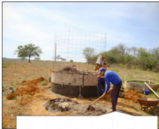
Preparo do solo e estruturação de uma caixa d'água
