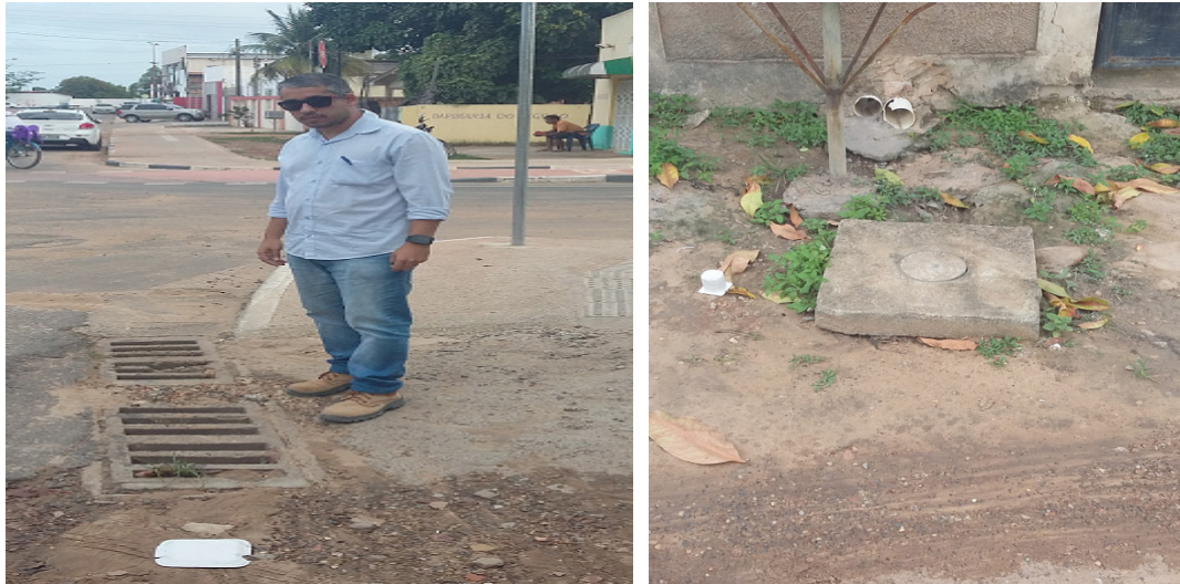
Figura 06: A - Rede de drenagem da Rua Edson Castro. B - Til residencial da Rua Edson Castro.
