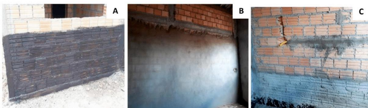
Figura 05: **A** - Impermeabilização externa; **B** – Chapisco; **C** - Reboco com impermeabilização interna.
