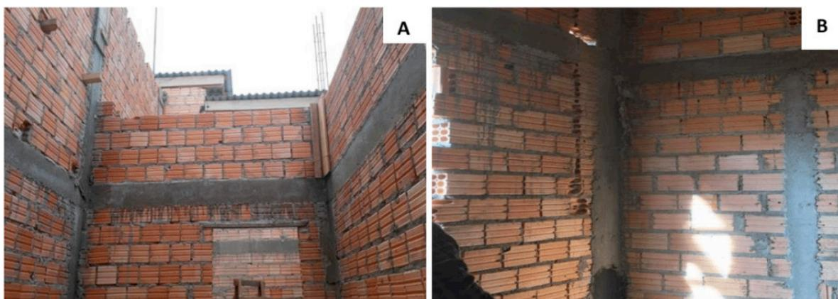
Figura 07: **A** -Amarração entre a coluna e a viga; **B** - Fragmentos de material desnecessário e prejudicial ao concreto.
