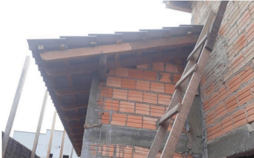
Figura 10. Coberta com telhas de concreto.
