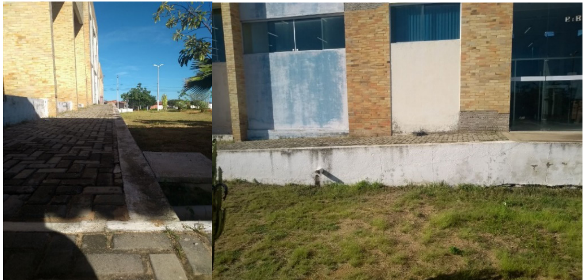
Figura 2 – Rampa de acesso à biblioteca.
