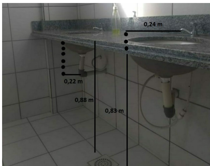
Figura 14 – Lavatórios dos banheiros.
