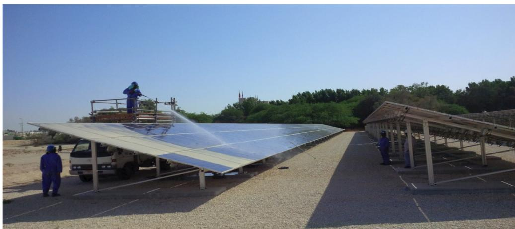
**Figura 1:** Módulos fotovoltaicos PV instalados na “University of Bahrain” (UoB). Composta por 2.088 painéis fotovoltaicos (policristalino), área total de 3.400 m<sup>2</sup>. FONTE: ALNASER et al, (2015).
