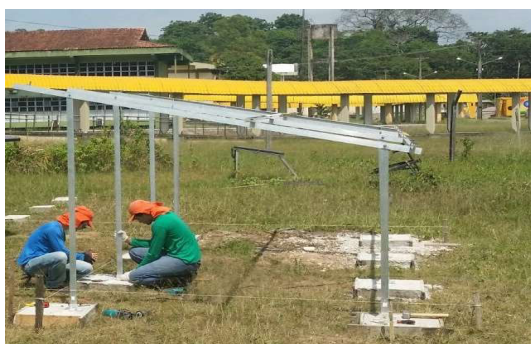
Figura 11 - Montagem das estruturas.
