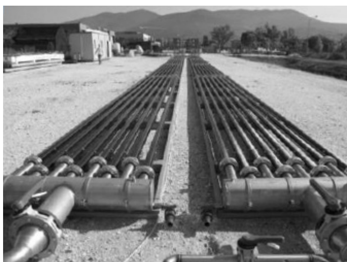
Figura 2.5 – Exemplo de fotobiorreator tubular tipo manifold
