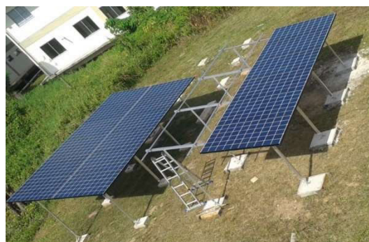
Figura 12 - Instalação dos GFV-04 e GFV-05.
