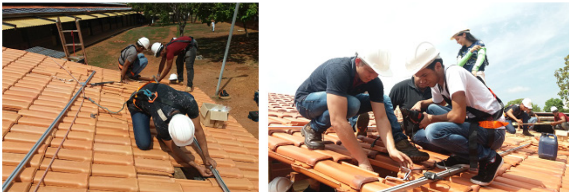
Figura 12- Realização prática da montagem das estruturas de fixação dos módulos fotovoltaicos.
