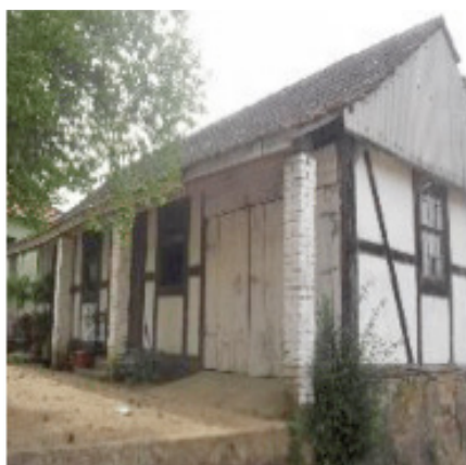
Figura 3: Casa Enxaimel estrutura de madeira encaixada, com seus vãos preenchidos com tijolo ou taipa.
