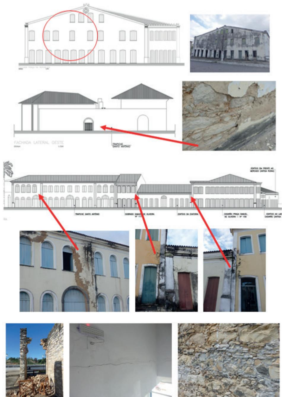
**Figura 4-** (acima): Fachada da Biblioteca (Casarão do Oitão) e vista geral do estado de conservação atual; (centro): Fachada lateral esquerda do campus e degradações com perda do reboco e Fachada principal do Campus de Laranjeiras e degradações das mais variadas; (abaixo): Queda de um dos arcos em abril de 2017, Fissuras no Casarão 159, Uso de cimento para preenchimento de lacunas nas paredes de pedra.
