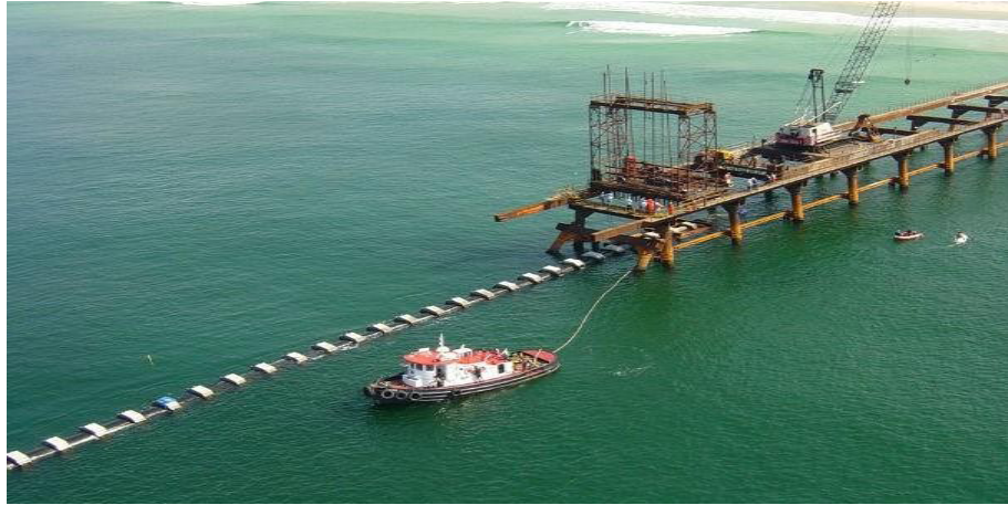
Figura 4 - Emissário submarino da Barra da Tijuca no Rio de Janeiro
