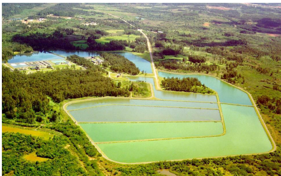
Figura 3 - Lagoas de estabilização
