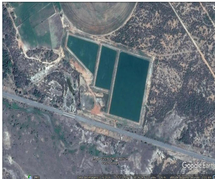
Figura 9 - Lagoas de estabilização.
