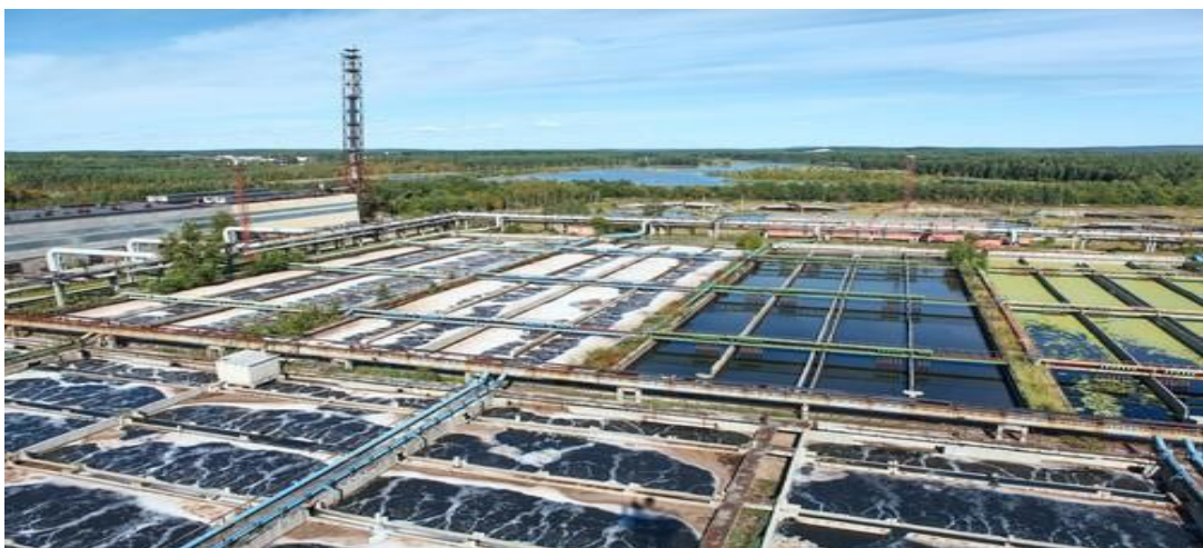
Figura 5 - Estação de tratamento de esgoto.
