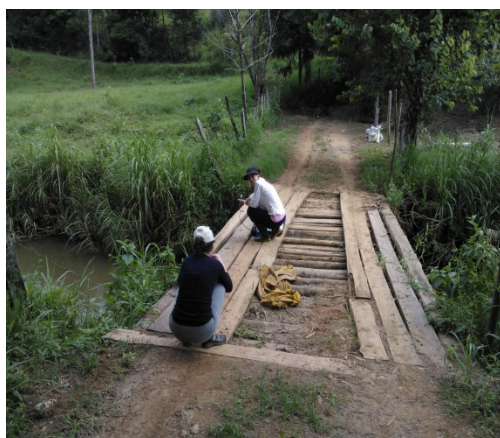
P8 – Pontilhão no 2/3 do córrego São Mateus
