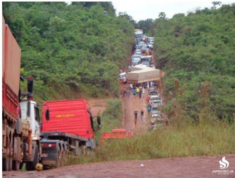
Figura 2 - MT-110 e MT-100 em péssimas condições de trafegabilidade Fonte: Associação dos Produtores de Soja e Milho do Estado de Mato Grosso (2014)
