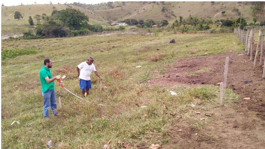
Figura 03. Escolha e marcação da área para uma fossa (Novo Oriente de Minas)
