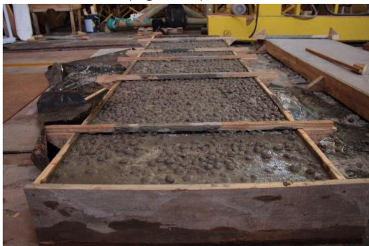
Figura 9 - Laje após concretagem.
