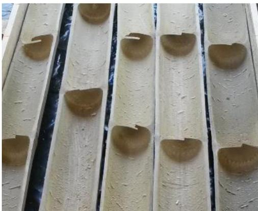
Figura 1 - Laje sem nós. Fonte: Elaborado pelos autores.
