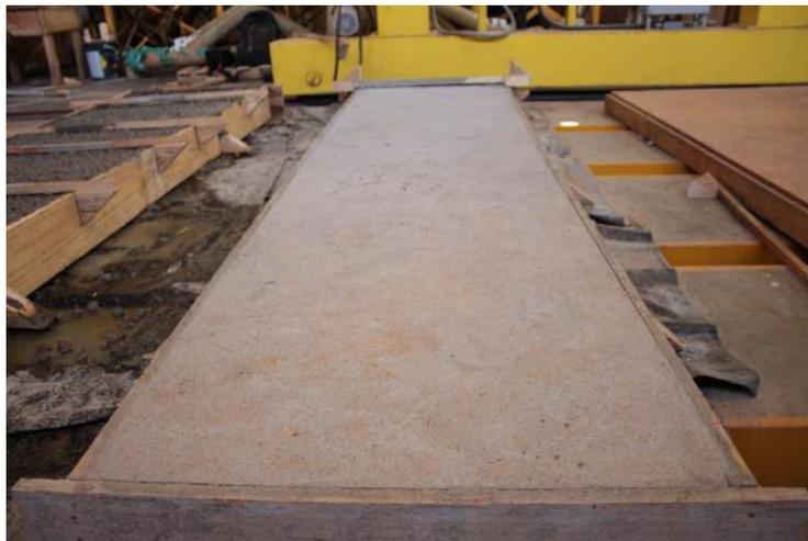
Figura 10 - Laje após regularização da capa.
