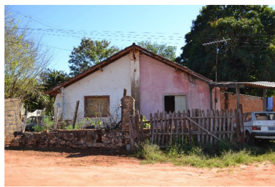
Figura 8 – Casas geminadas, vila ferroviária de Brotas. Fonte: INOUE, 2013
