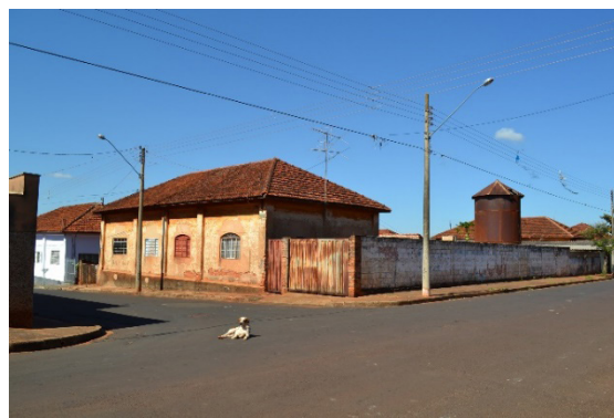
Figura 2 – Casas geminadas, vila ferroviária de Itirapina.
