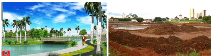
Figuras 13a; b; c; d: Projeto e construção do Parque Ambiental Ipiranga.
