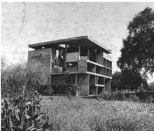
1. Villa Shodhan na época da construção. LE CORBUSIER, 1987, p. 304.
