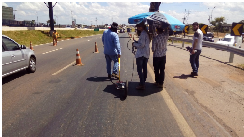
Figura 3 - Fotografia evidencia a aquisição de dados de GPR com o sistema SIR3000 acoplado a uma antena blindada de 900MHz.
