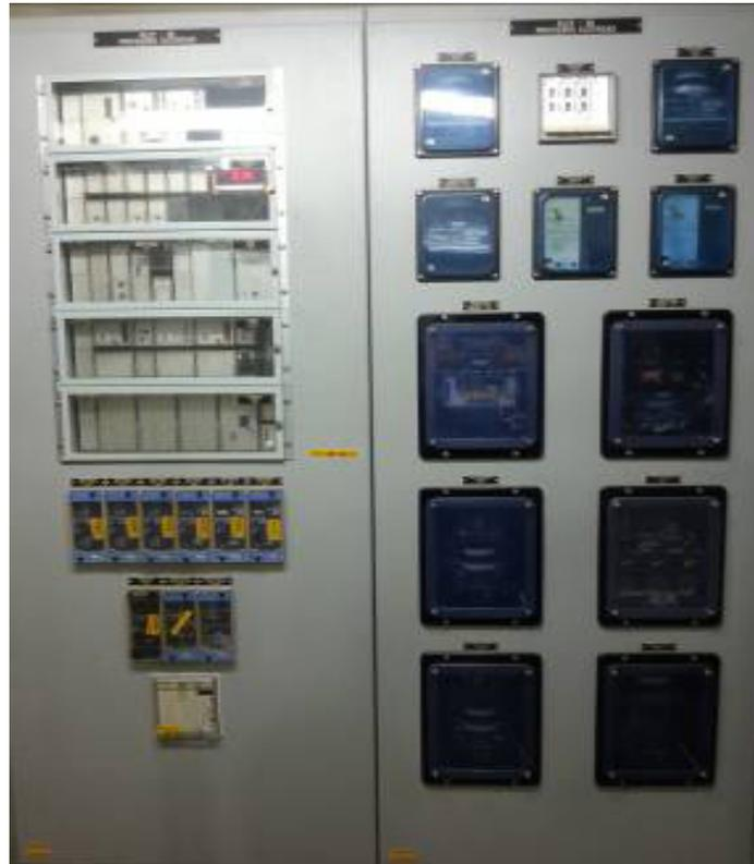
Figura 6: Painel dos Relés Proteção (antigo)
