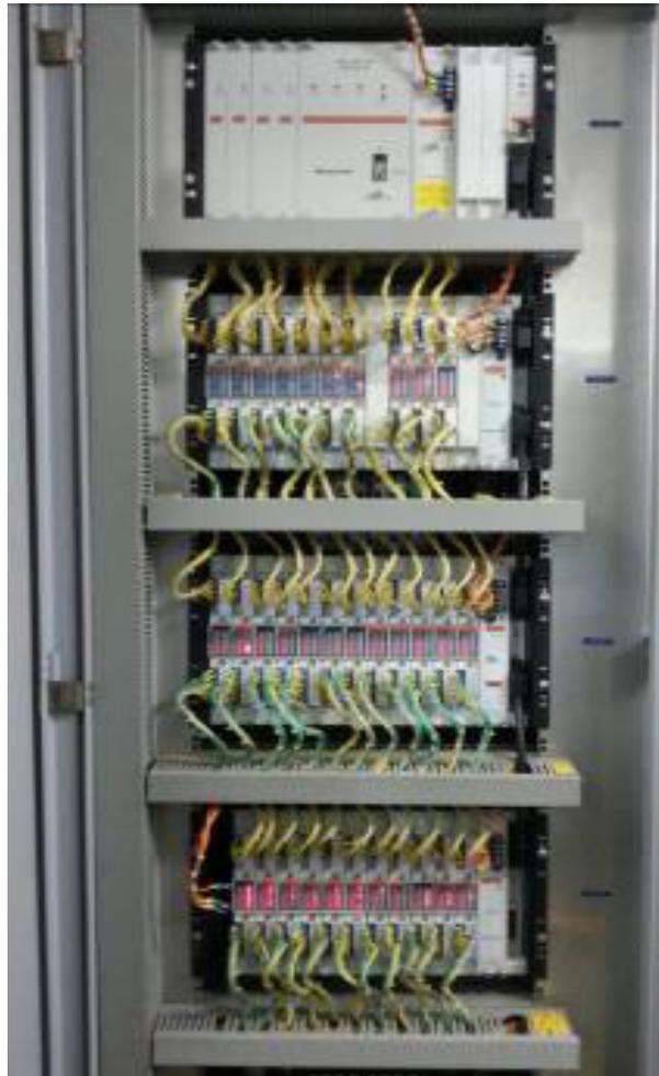
Figura 4 :Painel do Controlador Lógico Programável (antigo)
