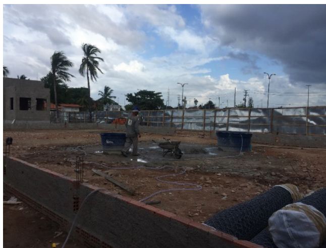
Figura 06: Quadra da praça durante acompanhamento de obra em 22 de julho de 2015.
