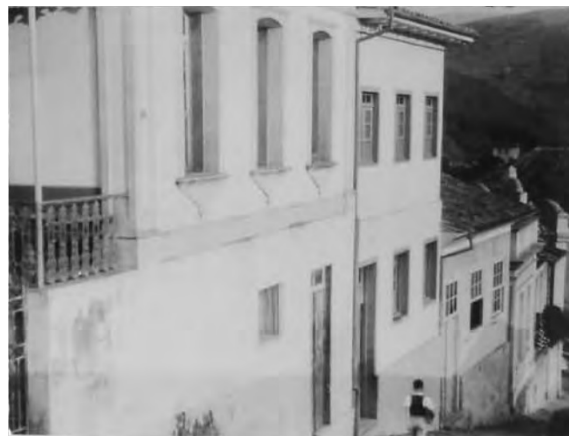
Figura 16: Vista da Rua Randolpho Bretas, atual Rua da Escadinha em 1949. Fonte: Sorgine (2008, p. 123)
