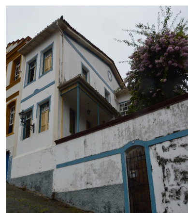
Figura 14: Edificação número 15 atualmente, após receber alterações. FONTE: Paula Ribeiro, 2017
