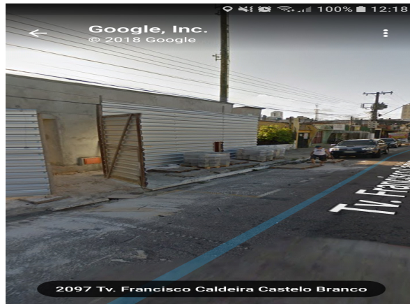
Figura 8 – Disposição inadequada de resíduos da construção civil.
