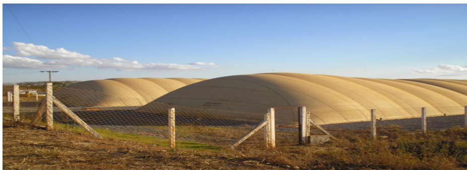
Figura 7. Imagem de um biodigestor anaeróbico, modelo japonês.
