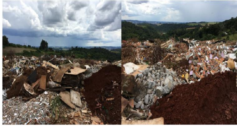
Figura 2 – Aterro inapropriado para disposição de resíduos sólidos
