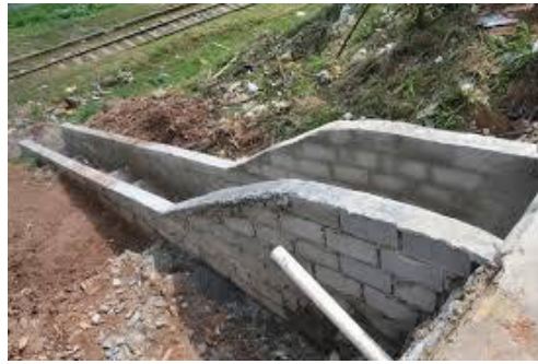
Figura 12. Canaleta para o desvio da água. Imagem ilustrativa. IFMA, 2015.
