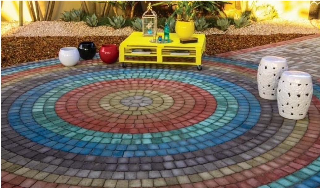
Figura 2 - Detalhe do Piso em Blocos de Concreto Colorido. FONTE: UOL Mulher
