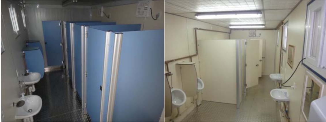
Figuras 03 - Banheiros no container
