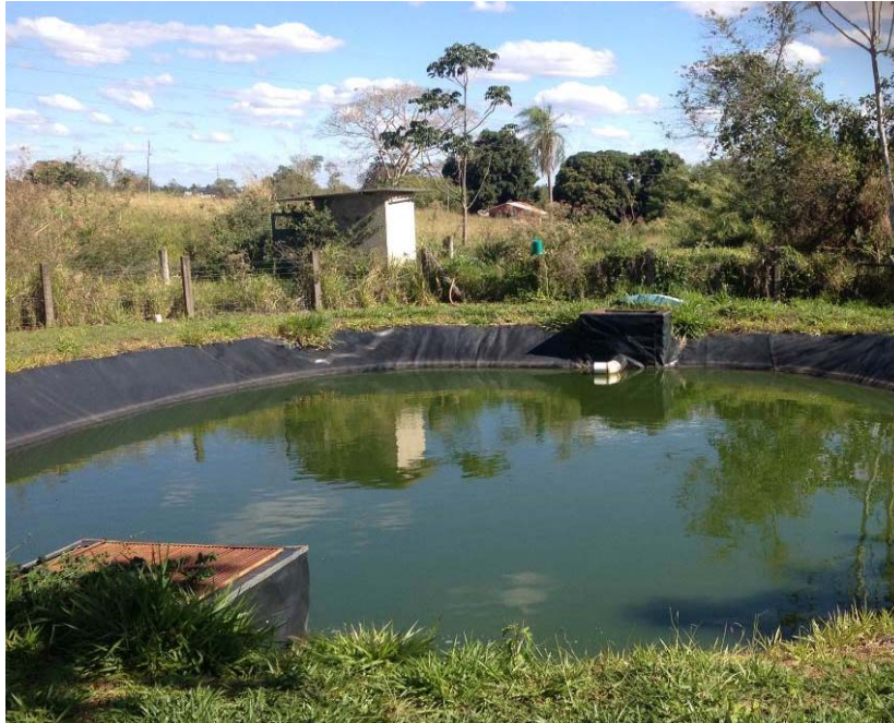
Figura 2. Terceira lagoa de tratamento
