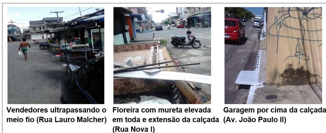
Figura 6: Obstruções nas calçadas fazendo o pedestre caminhar no meio da rua, na área periférica de Belém.
