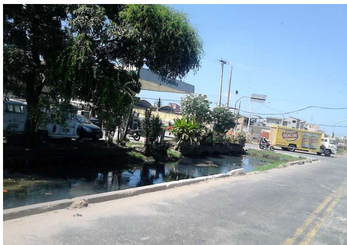
Figura 4. Vista de ausência de passeio Fonte: Pesquisa de campo (Av. Bernardo Sayão)
