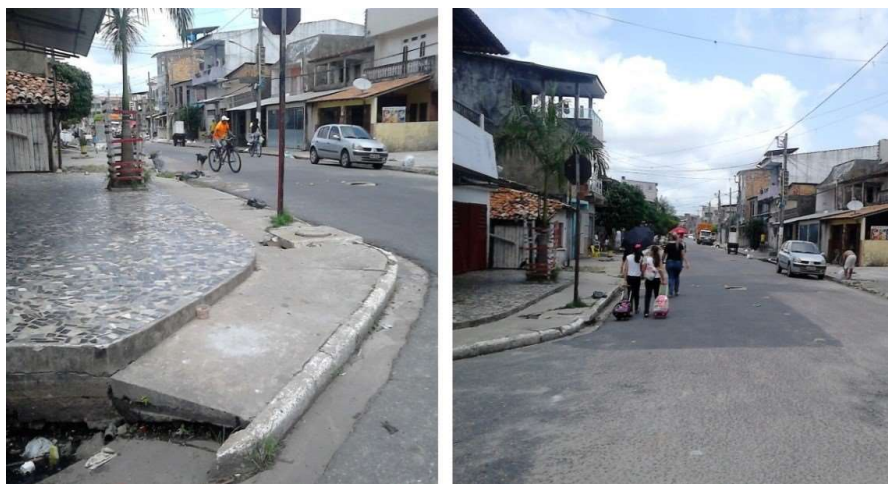
.Figura 12. Vista de esquina sem rebaixamento
