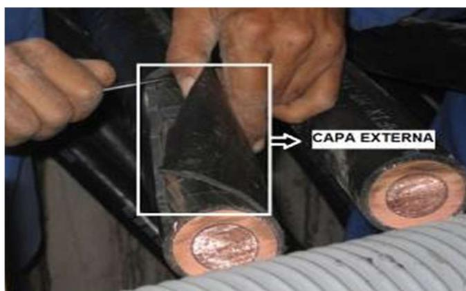
Figura 4- Retirada da capa externa do cabo.
