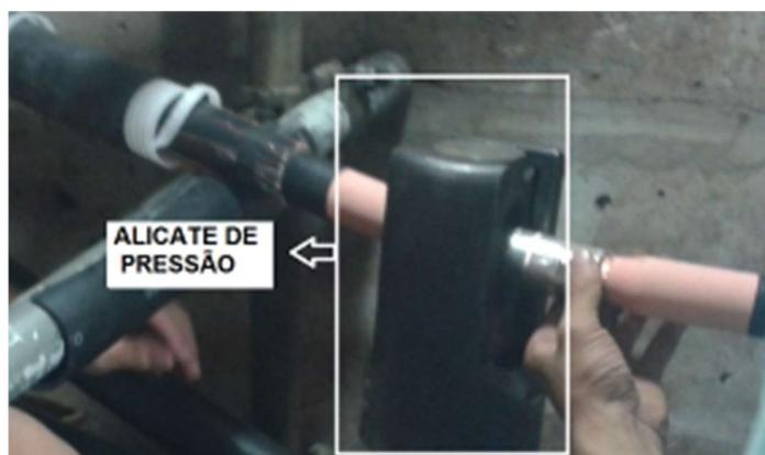
Figura 8- Utilização do alicate de pressão para fixação do conector.
