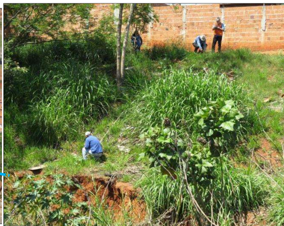
Figura 6 – Realização de medições para elaboração do estudo de estabilidade do talude marginal esquerdo, próximo à passarela de pedestre.
