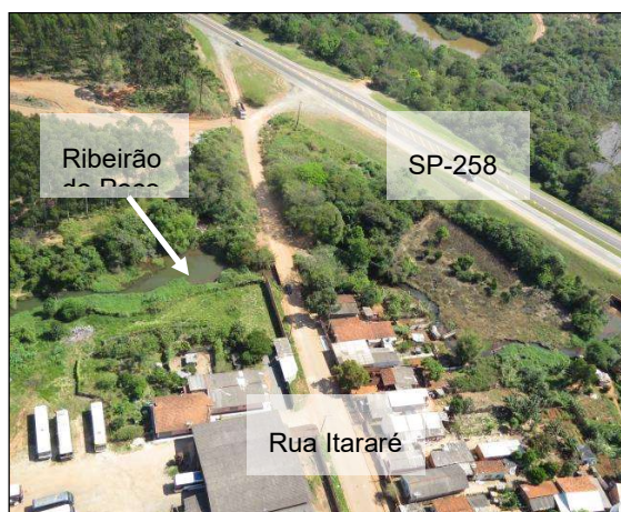
Figura 3 – Vista geral da área CPB-02 - Vila Jardim São Francisco.
