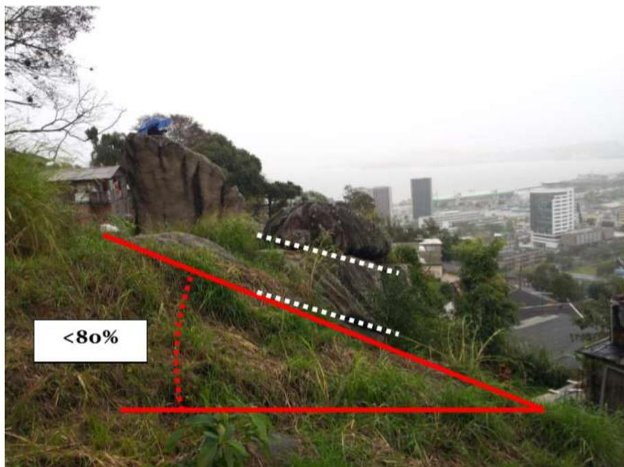
Figura 8 – Vista do talude e do Sistema de fratura com inclinação média <math><80\%</math>. As linhas tracejadas em branco mostram os planos de fraturas.
