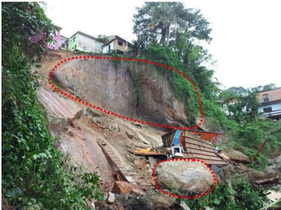
Figura 5 - Decomposição esferoidal em blocos verificados após o deslizamento.
