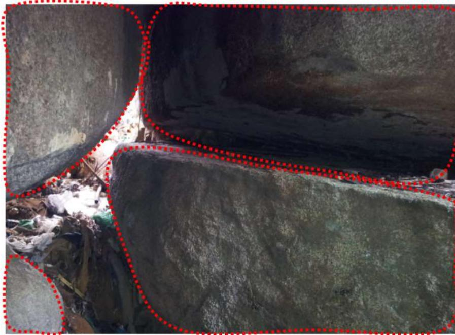
Figura 9 – Decomposição esferoidal nos blocos.
