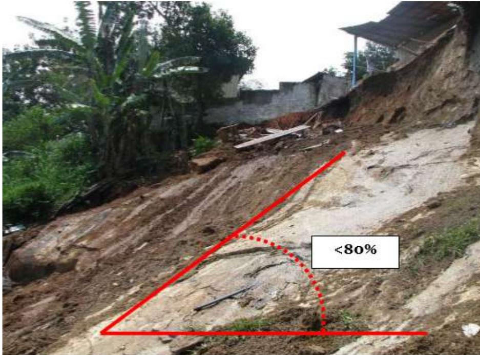
Figura 2 – Vista do talude e do sistema de fratura com inclinação <80% e faces lisas e com argilização das fraturas.
