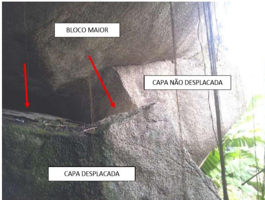
Figura 10 – Vista de uma parte do bloco maior que já deslocou e uma parte que ainda está intacta.
