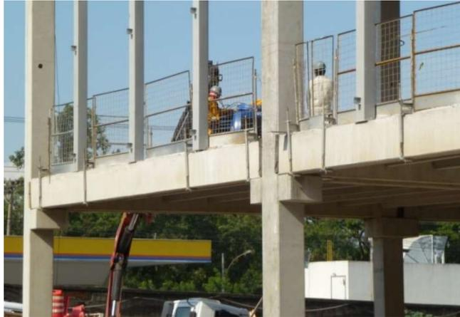
**FIGURA 5** – Instalação inadequada de guarda-corpo
