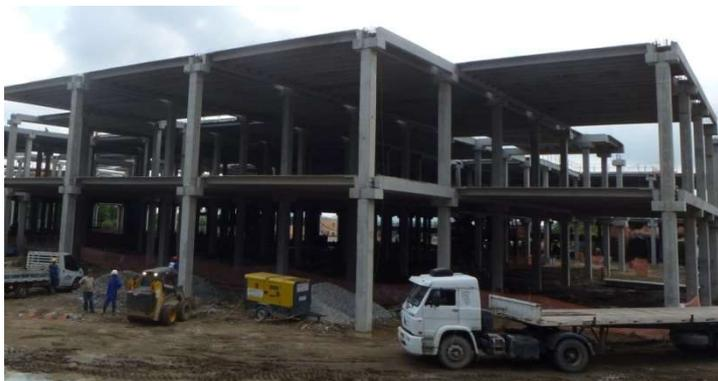
**FIGURA 4** – Obra na fase de montagem da estrutura com pré-moldados
