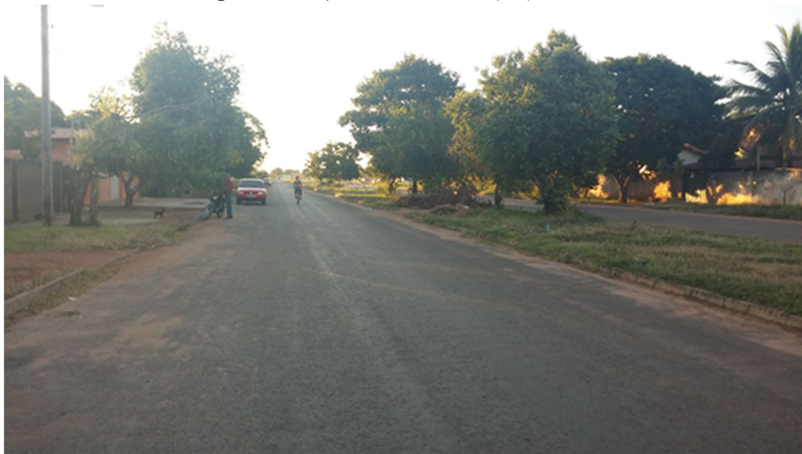
Figura 06: Rua pavimentada, Arinos (MG) em 2015
