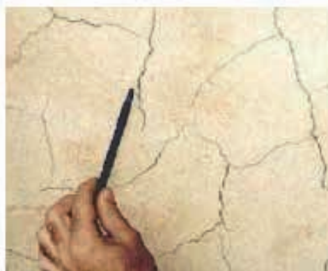
Figura 01 – Fissura em argamassa de revestimento
