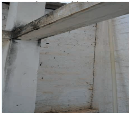
Figura 02 – rachaduras na junção de paredes
