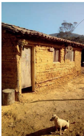
Figura 5 - Construção realizada na Ocupação Chico Rei com a técnica de pau-a-pique.
