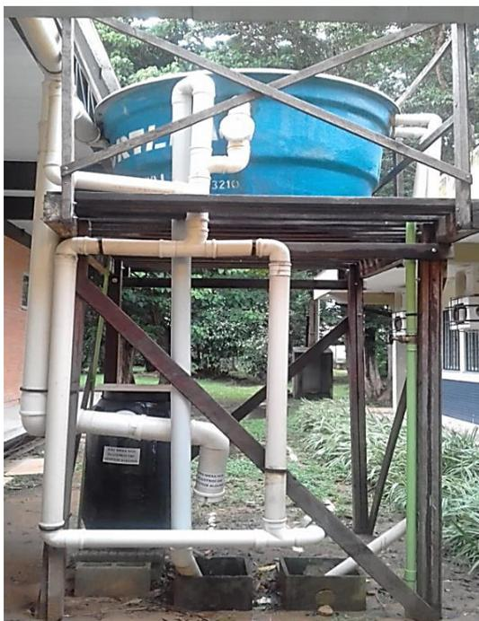
**Figura 1-** Sistema de captação da água da chuva instalado no NUMA.
