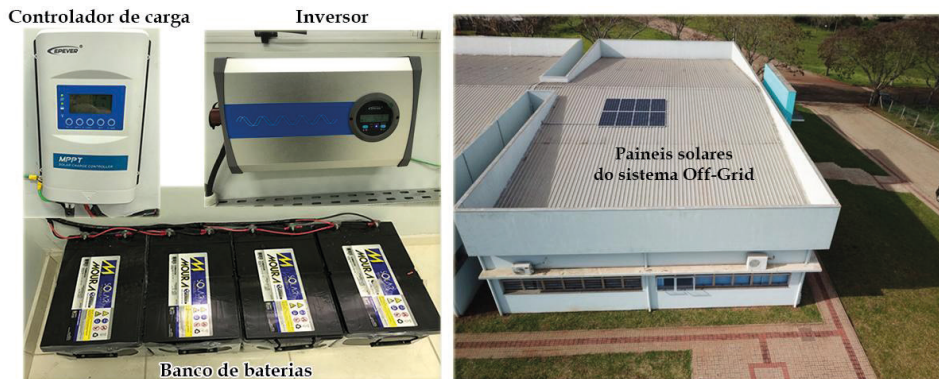
Figura 5. Registro da instalação Off-Grid no Tecno-URI Missões.
