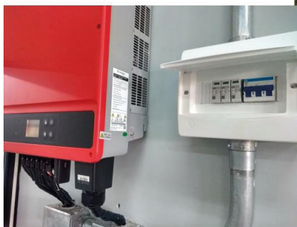
Inversor e sistema de proteção
