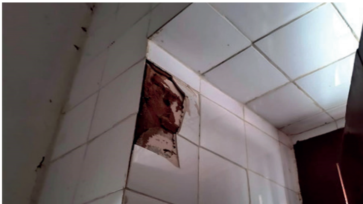
Figura 5: Deslocamento de revestimento cerâmico em parede do Casarão.
