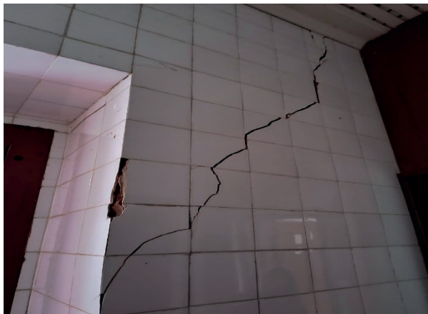
Figura 3 (b): Parede com revestimento presente na parede do Casarão. de pintura exibindo rachadura.
