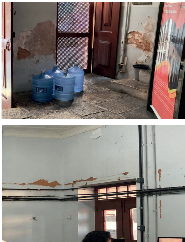
Figura 6: Descascamentos da pintura nas paredes do Casarão.
