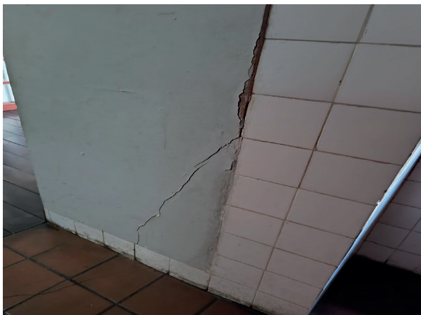
Figura 2 (a): Fissura Inclinada na Edificação.
