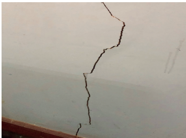
Figura 3 (a): Rachadura em cerâmica
