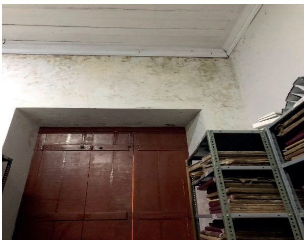
Figura 4: Manchas de umidade e bolor ocasionadas por infiltração no Casarão.
