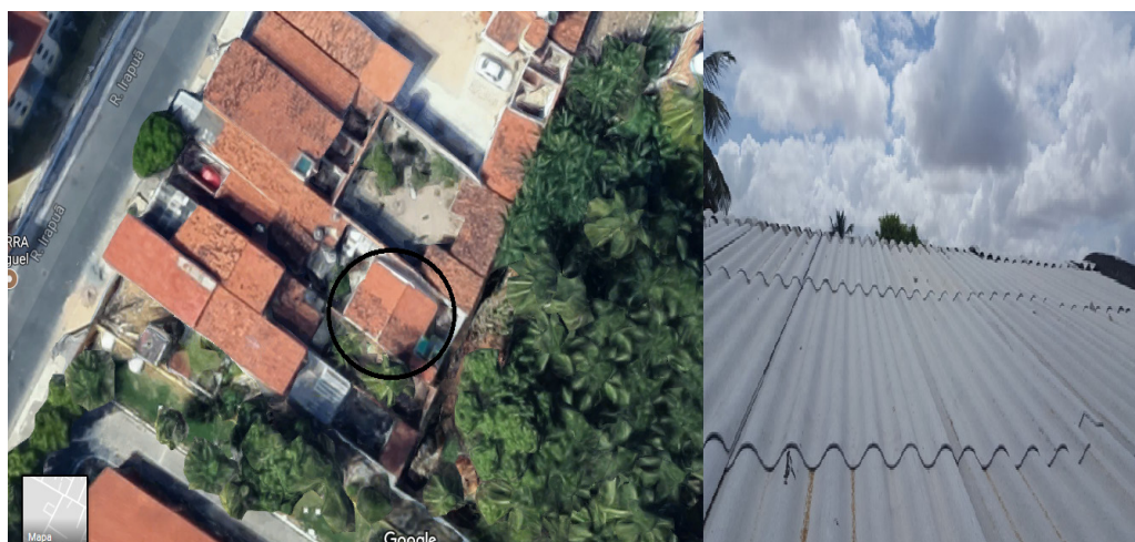
Figura 02 - Vista superior do telhado da residência
