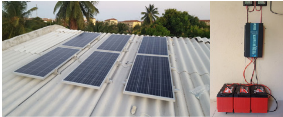
Figura 05 - Painéis fixados no telhado
