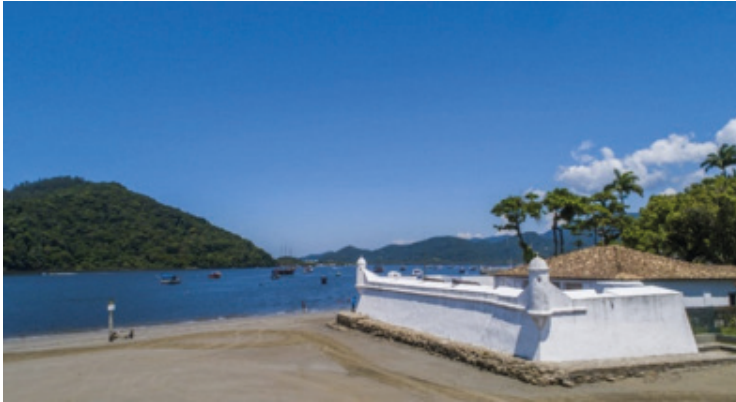
Figura 3 - Forte São João da Bertioga - Marco Zero do município
