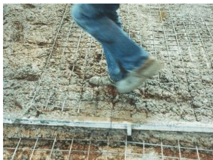
Figura 10 – Trânsito de operário sobre a armadura. (Granato, 2014).
