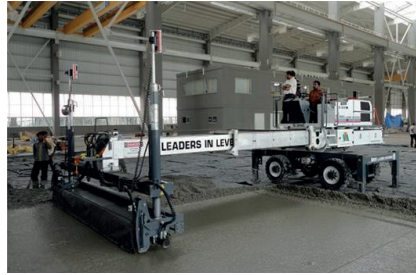
Figura 11 – Equipamento do tipo Laser Screed. (Aquarius Tech, 2017)
