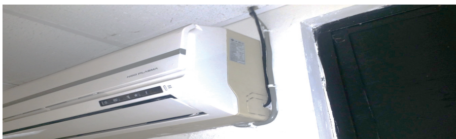
Figura. 5 Instalação dos cabos de sinal para o ar condicionado
