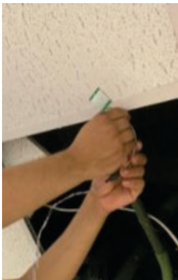
Figura. 4 Instalação do sensor de movimento (PIR)
