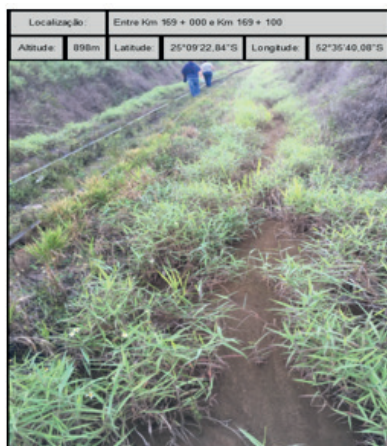
Figura 12 - Vegetação invadindo a Via Permanente
