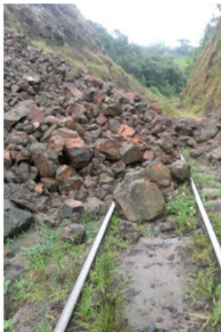
Figura 19 - Deslizamento de detritos.
