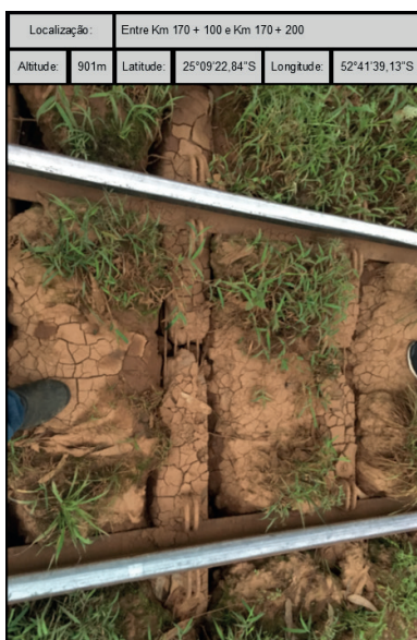
Figura 17 – Falhas nos dormentes
