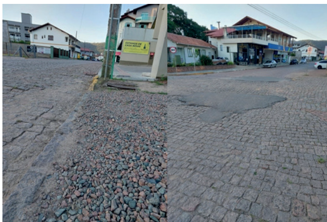
Figura 1 - Imagem da rua Hebert Zink, em Presidente Getúlio/SC. Calçadas inadequadas, pavimento irregular, ausência de espaço destinado para ciclistas e sinalização inexistente caracterizam a via.
