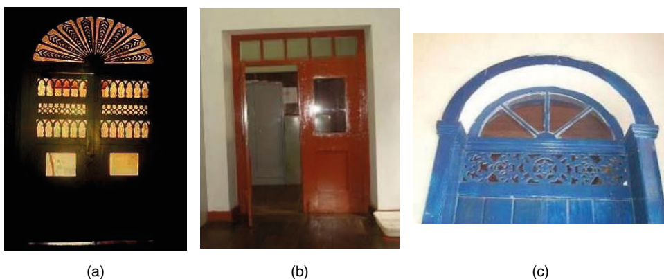
Figura 13: (a) Cancela interna, em madeira vazada; (b) Porta interna, com bandeira em madeira e vidro; (c) Bandeira em vidro e madeira vazada. Fotos: Margareth Figueiredo.
