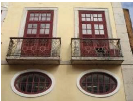
Figura 9: (a) Corte esquemático dos tipos de abertura das janelas; (b) Óculos e janelas rasgadas com parapeito sacado. Fonte: Foto e desenho Margareth Figueiredo.
