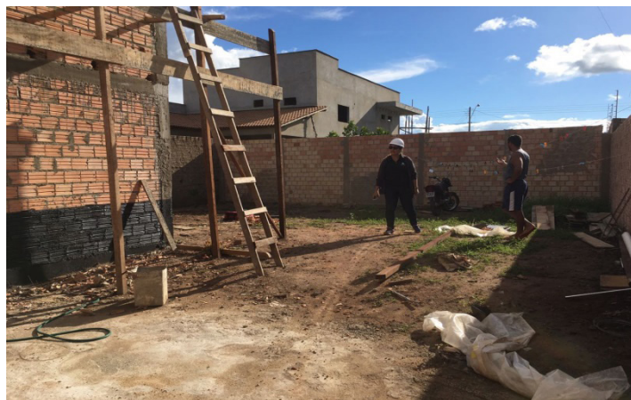
Figura 12 Desnível do terreno.
