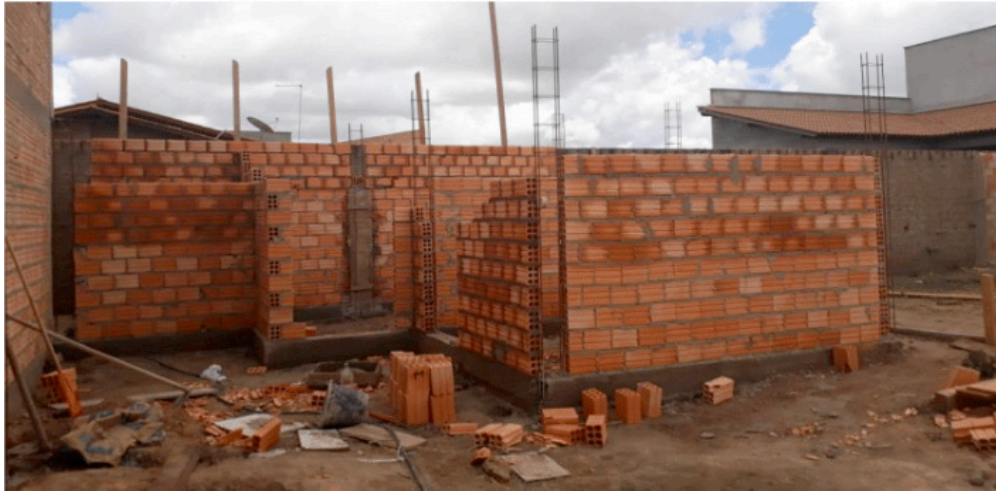
FIGURA 04. Alvenaria com tijolo cerâmico contendo seis furos cada.
