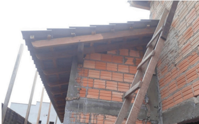
Figura 10. Coberta com telhas de concreto.
