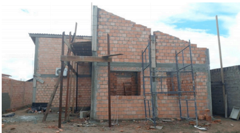
FIGURA 08. Inclinação para cobertura e a lateral da obra.
