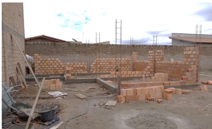
FIGURA 02. Viga baldrame Fonte:
