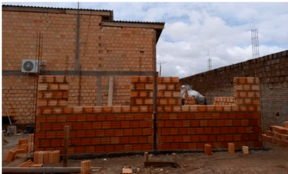
FIGURA 03. Assentamento de tijolo cerâmico com suas respectivas ferragens.
