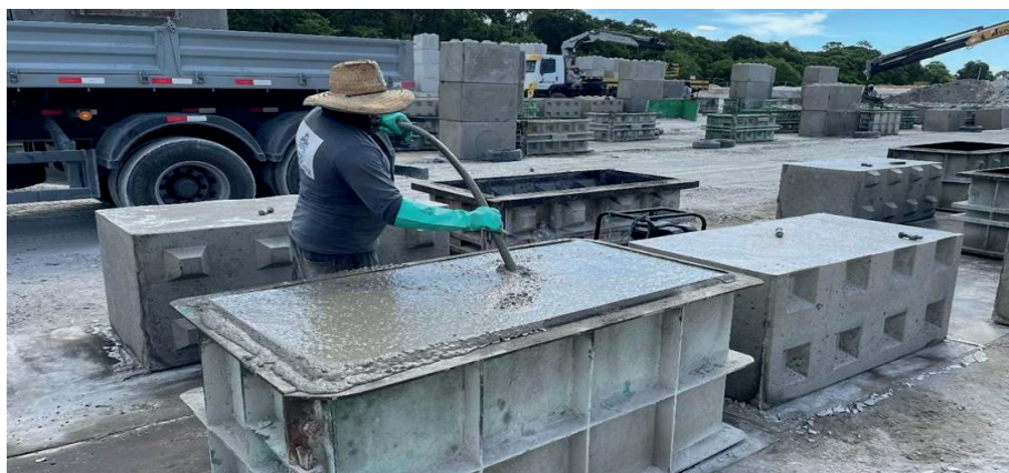
Figura 7 – Vibração do concreto lançado nas formas
