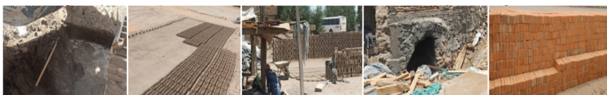
Figura 1. Proceso de la elaboración de ladrillo en la colonia “Las Terceras”, San Luis Potosí.
