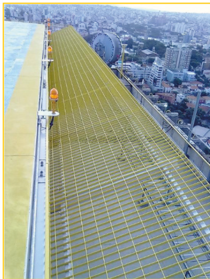
Figura 9 – Grade de segurança em heliponto elevado. Foto: internet
